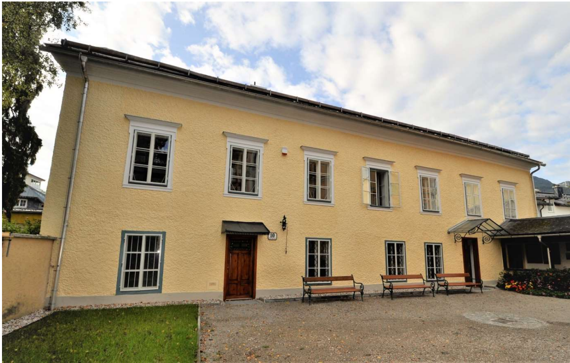
Abbildung 5: „Lehár- Stöckl“ nach Abschluss der Sanierungsmaßnahmen, 2021, Foto Thomas Nussbaumer
